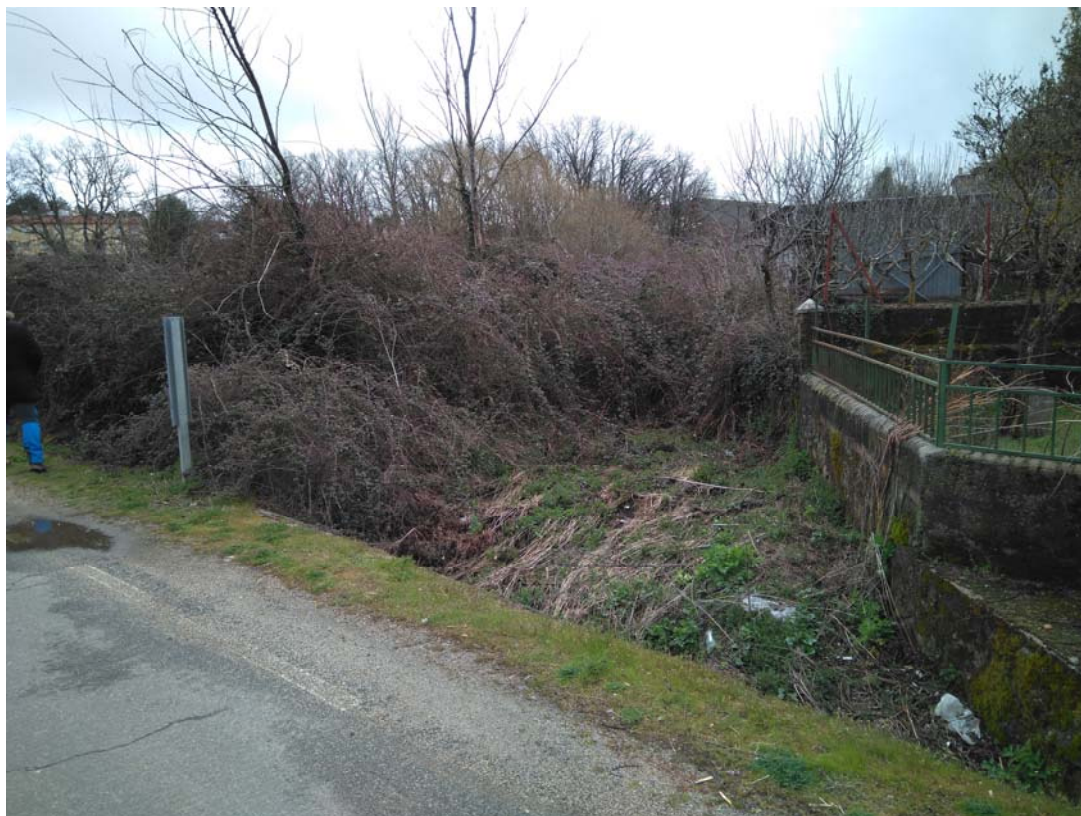
12 Vista hacia el sur del cruce del regato con la calle Guardia Civil, carretera SA-212. Fuente: Autor.
