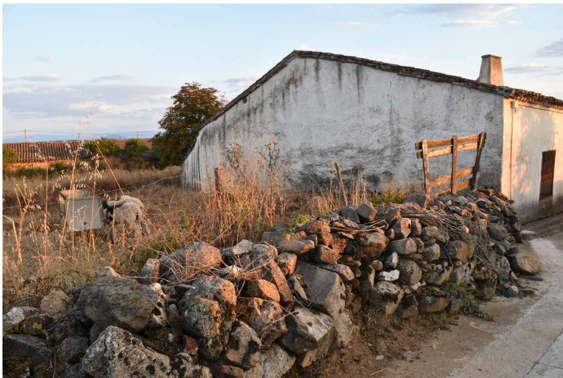
Figura 12: Imagen de la parcela n.º 1 utilizado como redil junto a edificación existente en parcela colindante.
