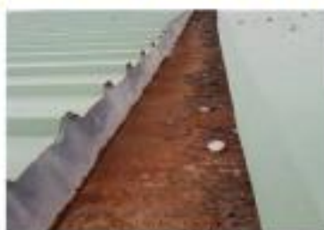
Detalle de la tubería de hierro
