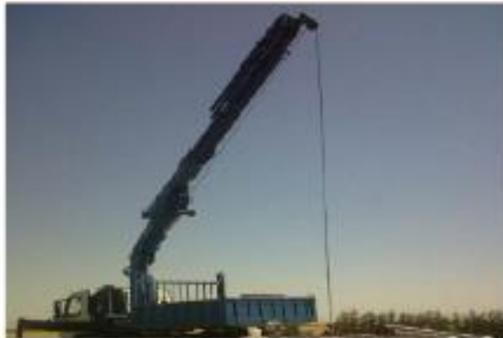
Detalle de Trabajos de Extracción de Tubería
