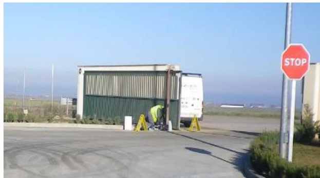
Detalle Trabajos de Reparación Puerta de Entrada
