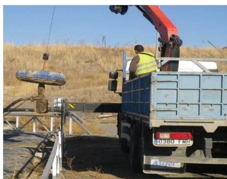
Detalle Trabajos de Extracción Bomba Balsa
