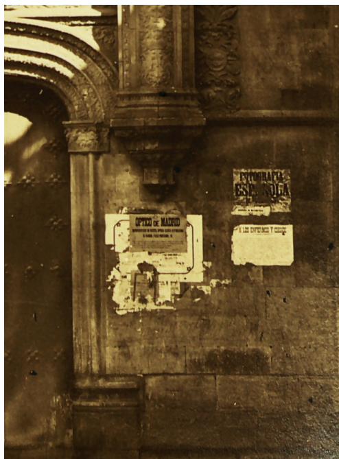
Juan Poujade. Detalle de la Fachada de la Universidad. Imagen propiedad del Archivo de la Universidad de Salamanca.
